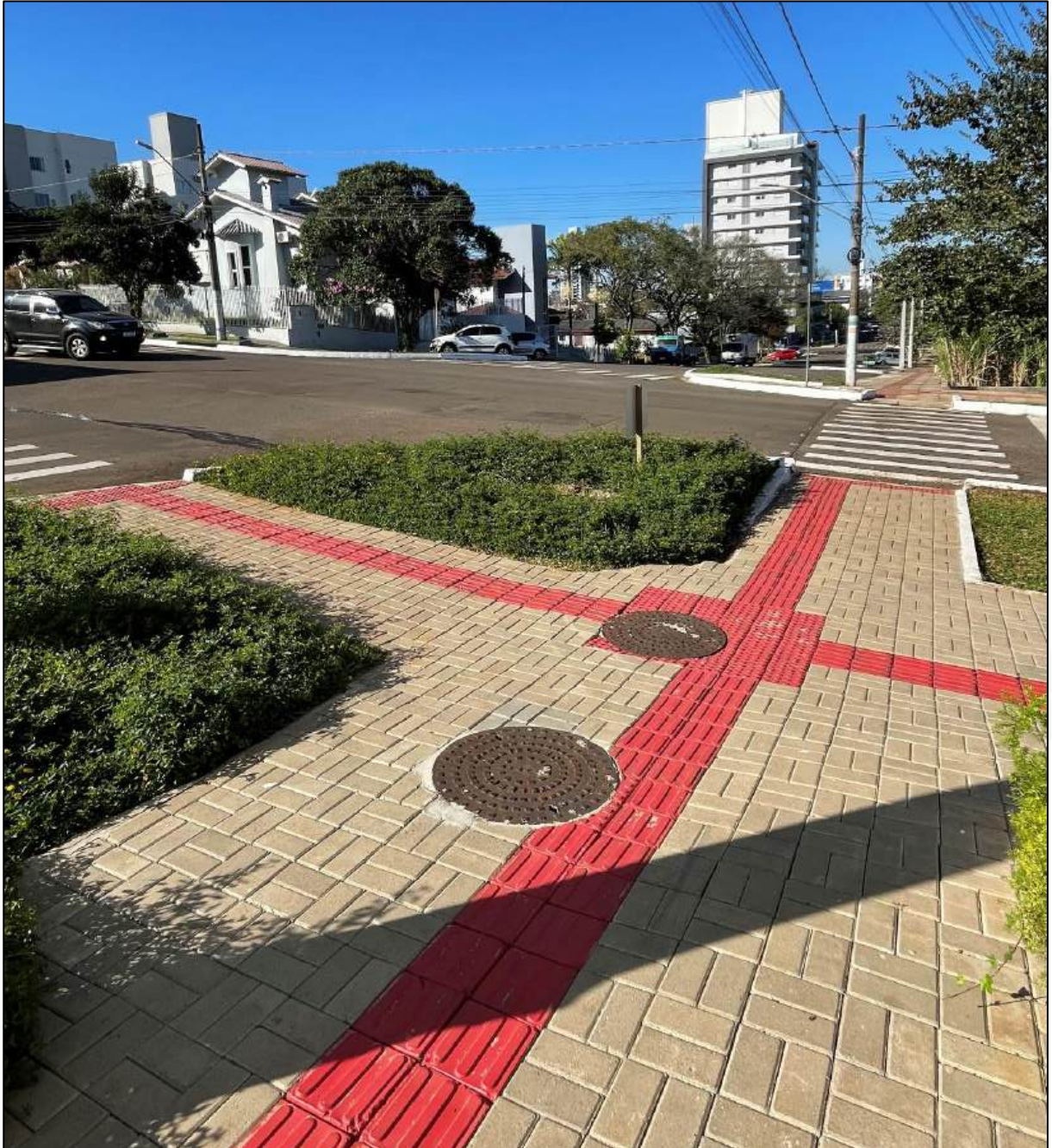
Figura 41 – Elemento obstruindo a sinalização tátil na rua Rui Barbosa
