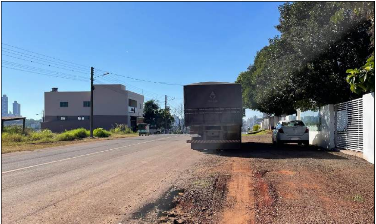
Figura 33 – Trecho da rua 7 de Setembro sem calçada
