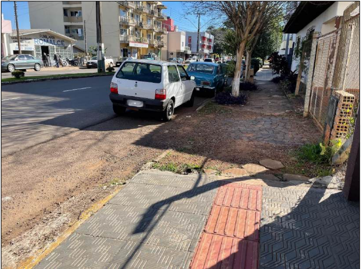
Figura 35 – Descontinuidade de calçadas na avenida Salgado Filho
