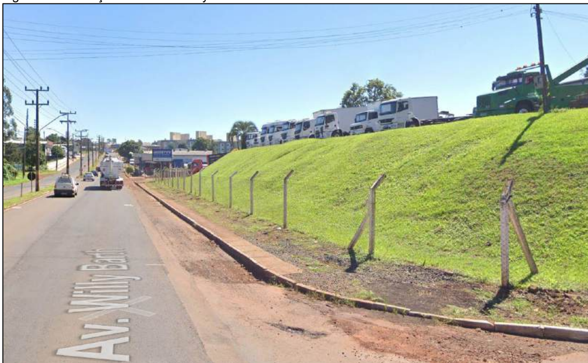
Figura 135 – Calçadas na Rua Willy Barth
