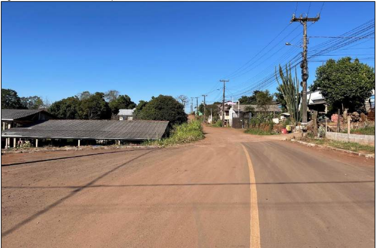
Figura 109 - Estreitamento de pista na rua Euclides da Cunha
