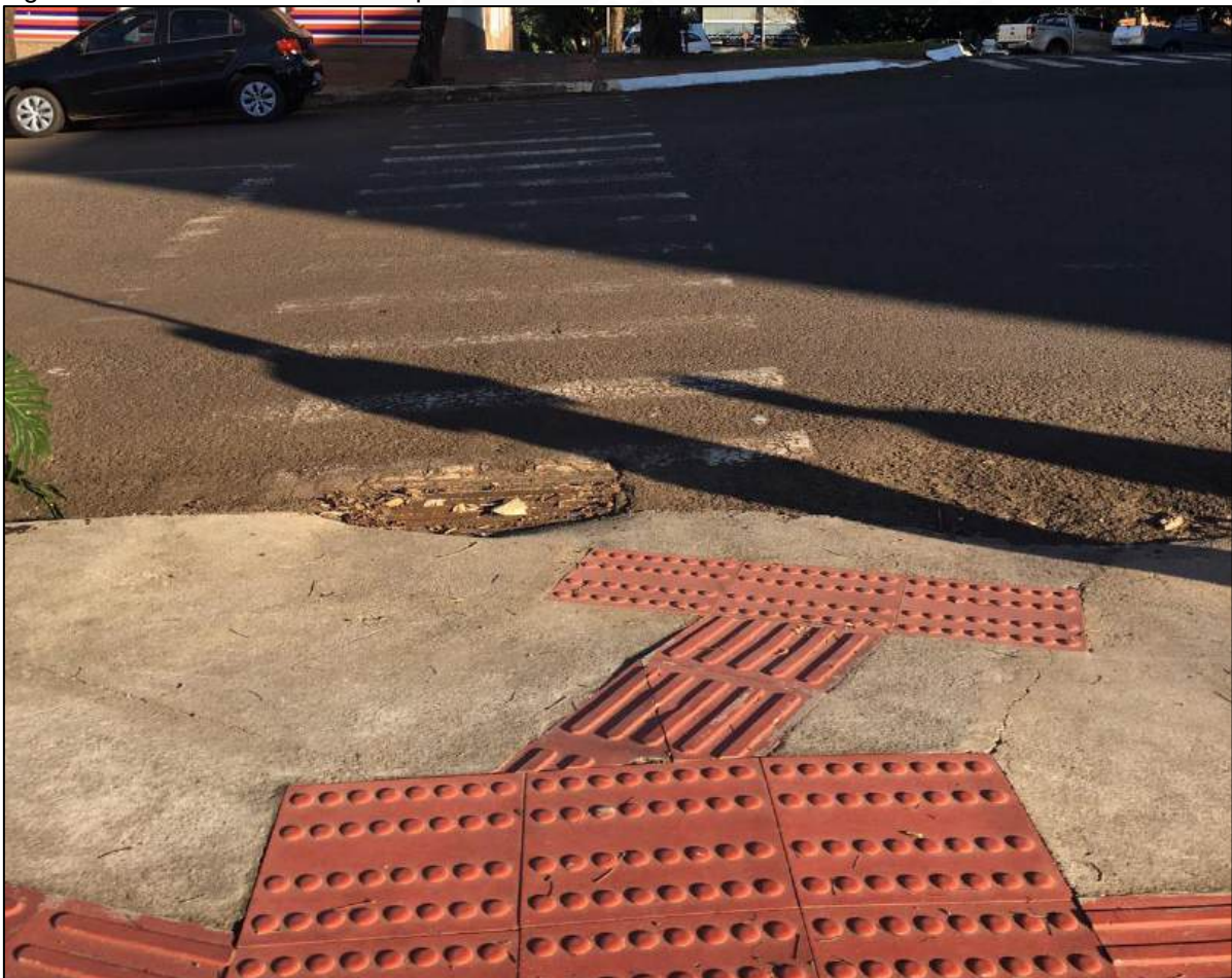
Figura 49 – Faixa de travessia de pedestres na rua Marcílio Dias
