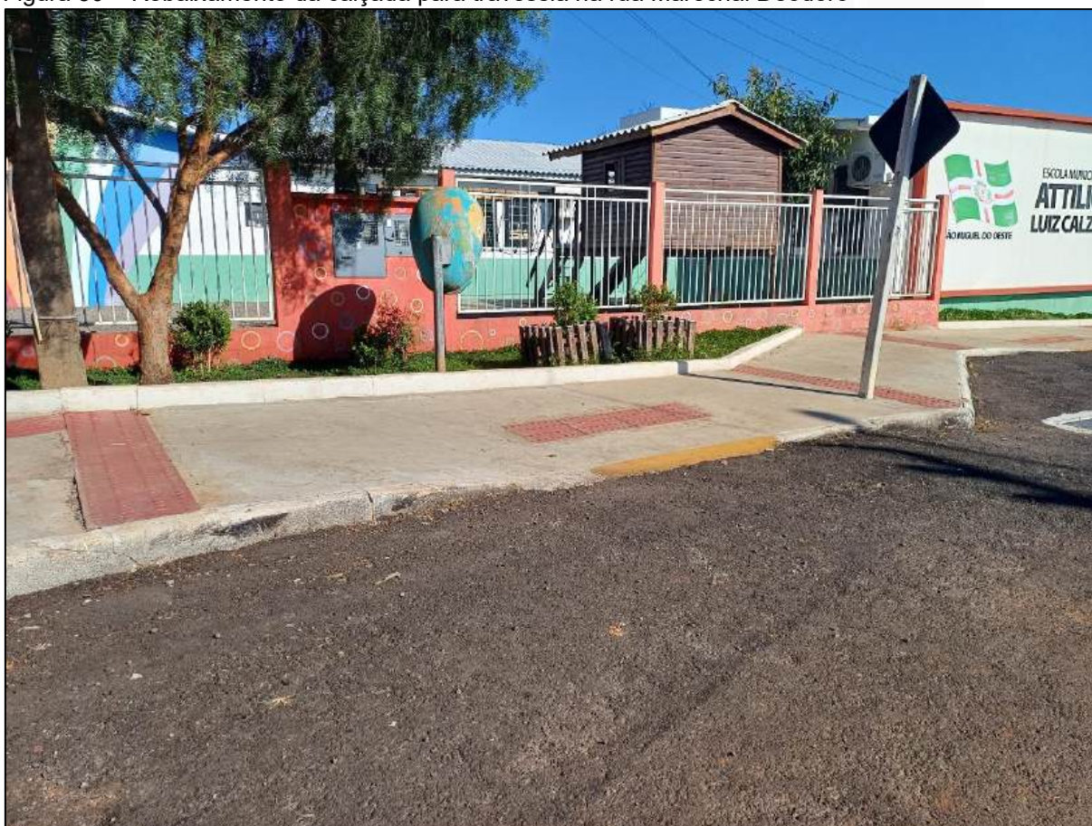
Figura 50 – Rebaixamento da calçada para travessia na rua Marechal Deodoro
