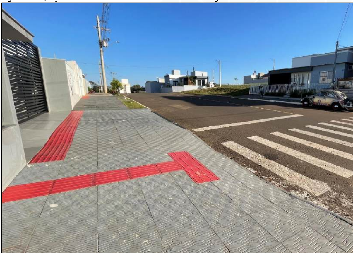
Figura 42 – Calçada executada corretamente na rua Irmão Miguel Fidélis
