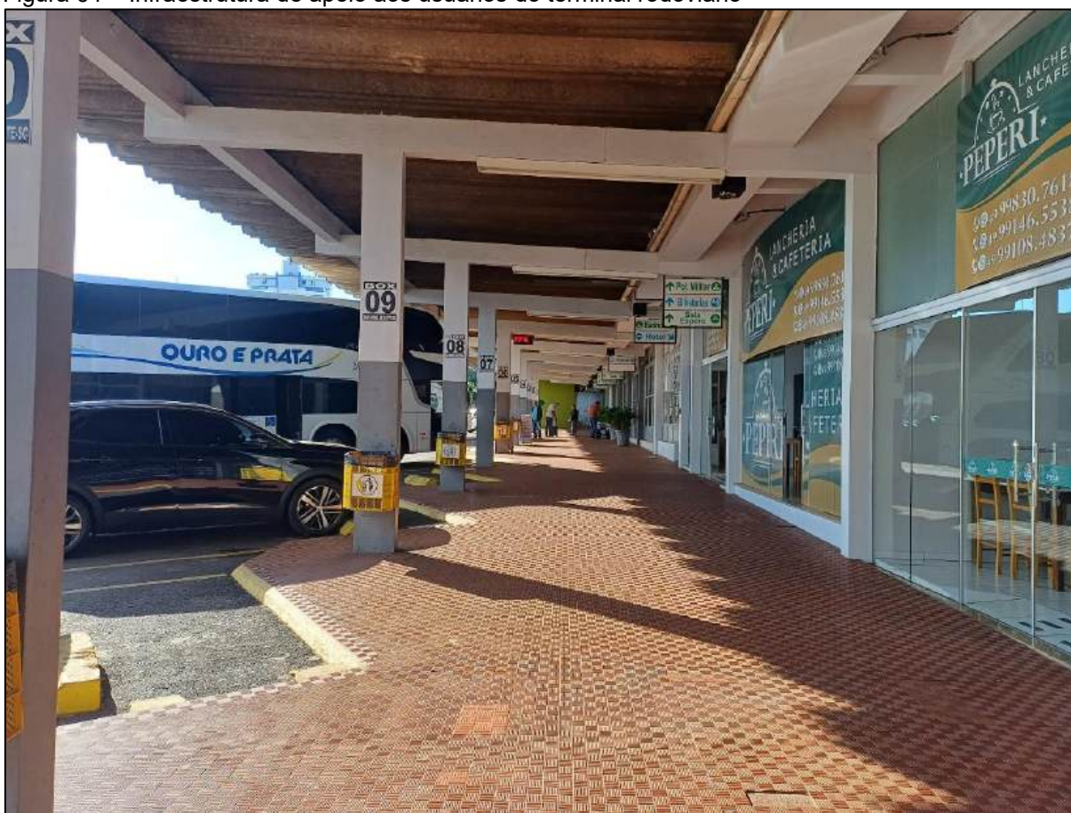
Figura 64 – Infraestrutura de apoio aos usuários do terminal rodoviário
